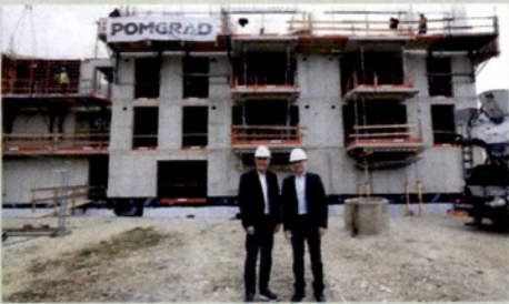
Predsednik uprave SSRS mag. Črtomir Remec in predsednik vlade dr. Robert Golob na ogledu gradbišča Ob Kobiljskem potoku v Lendavi (foto Mediaspeed)
